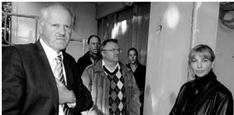
Rundgang auf der Baustelle der künftigen Geriatrischen Klinik: Mit dabei waren (von links) Klinikdirektor Axel Janischowski, Architekt Christof Preiß, Thomas Krug von S-Projekt, Sonja Berger (Ostalb-Klinikum) und die neue Chefarztin der künftigen Geriatrischen Klinik Iris Heßelbach. FOTO: KULLMANN
